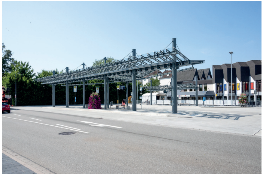
Neugestalteter zentraler Omnibusbahnhof Ramstein
