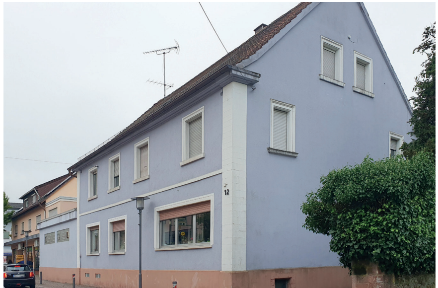
Gebäude mit mittlerem Sanierungsbedarf
