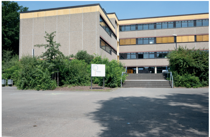
Realschule Plus im Bereich der Schernauer Straße
