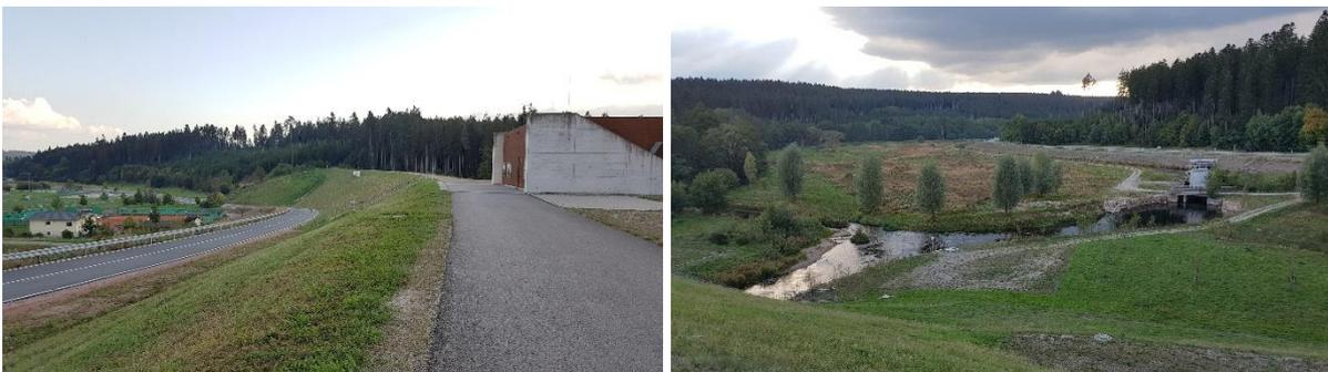
Abbildung 13 Beispiel Hochwasserrückhaltebecken Wolterdingen im Donau-Einzugsgebiet (max. Dammhöhe 18 m, Stauraum 4,7 Mio. m<sup>3</sup>, Bemessung auf ein 100-jährliches Hochwasser)
