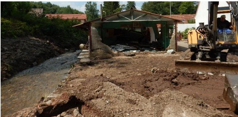
Abbildung 12 Eingestürzte Wand infolge Wasserdrucks (Beispielbild)
