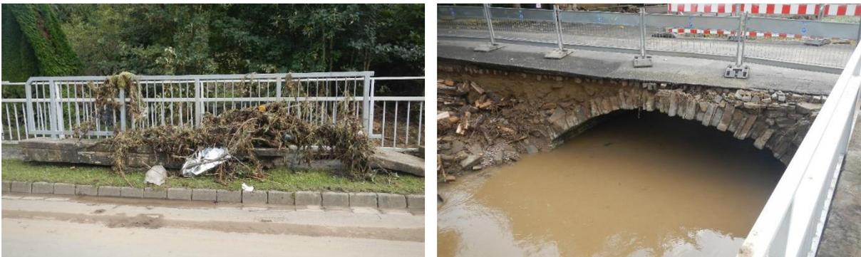
Abbildung 11 Treibgut und zerstörtes Brückengeländer infolge Wasserdrucks (Beispielbilder)
