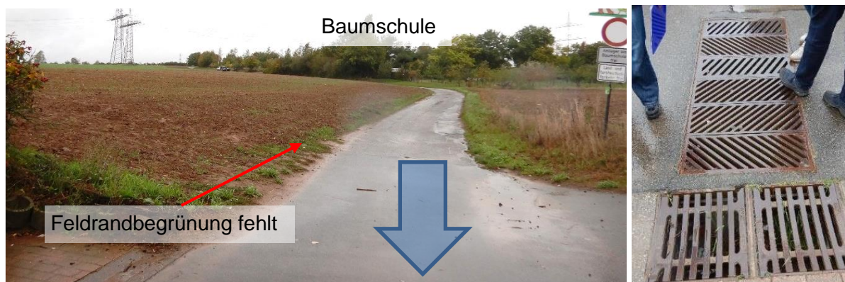
Abbildung 24 Wirtschaftsweg und Straßenablauf Dietschweiler Straße
