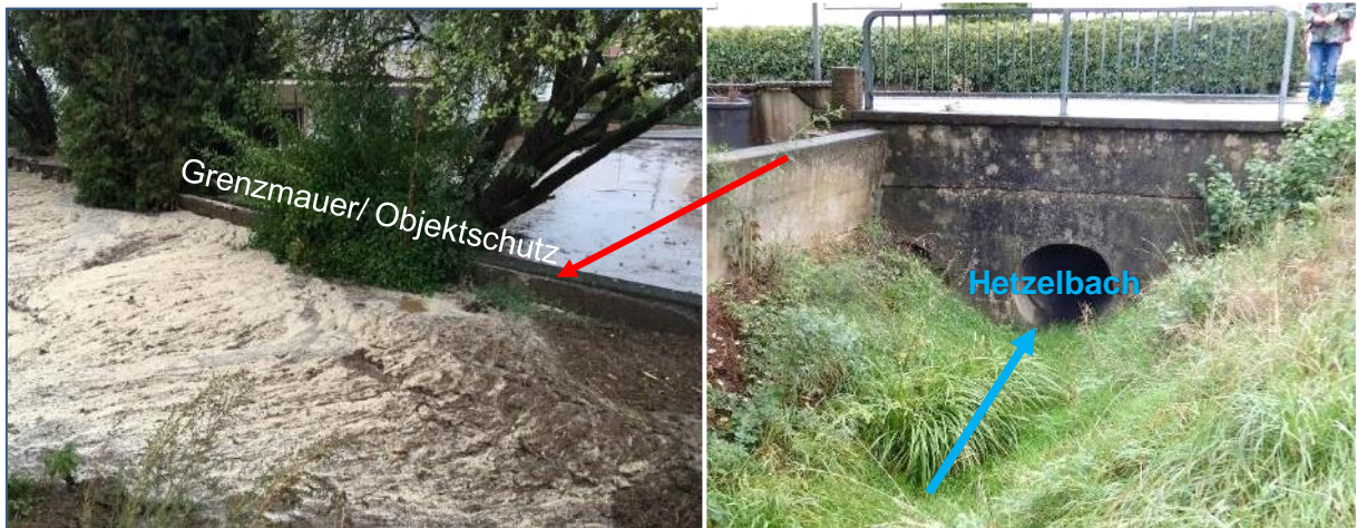
Abbildung 52 Durchlass Hetzelbach unter Brunnenstraße im Hochwasserfall
