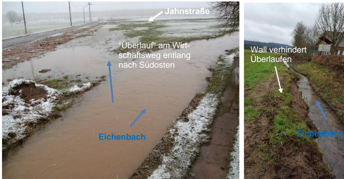
Abbildung 44 Verlauf des Eichenbachs bei Hochwasser (23.10.2010), rechtes Bild Januar 2018
