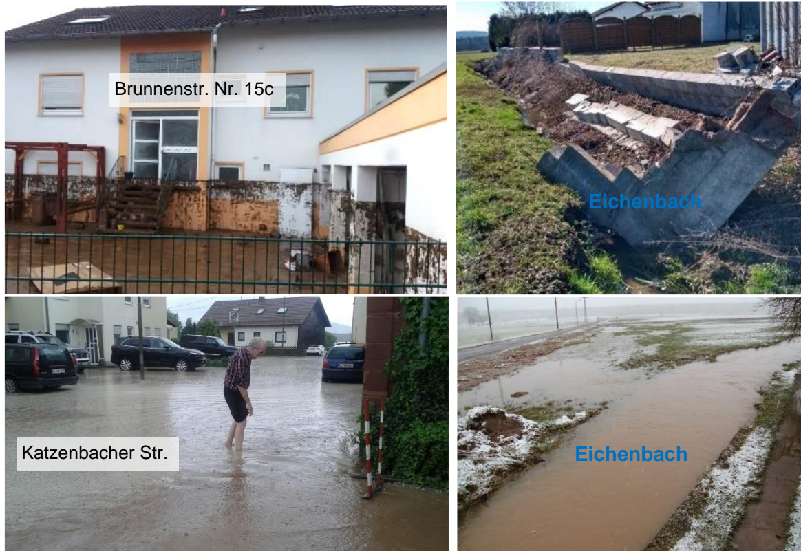
Abbildung 6 Überflutungssituation und Schäden bei Starkregeneignissen in Hütschenhausen
