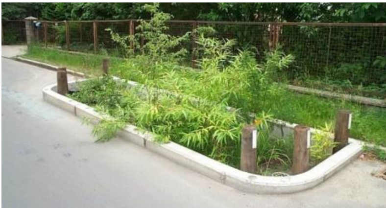
Abbildung 60 Beispiel Tiefbeetrigole (Quelle Projekt KURAS)
