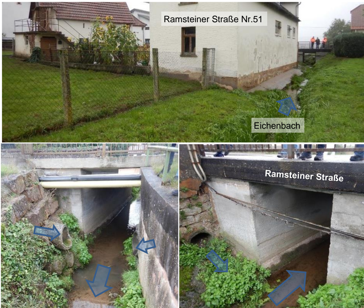
Abbildung 34 Brücke Eichenbach – Ramsteiner Straße
