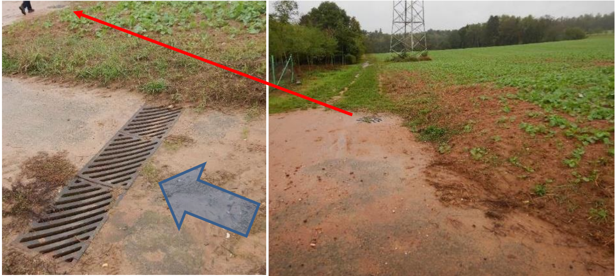
Abbildung 27 Wasserfassung vor Ortslage -> Ableitung in RRB Ziegelhütte
