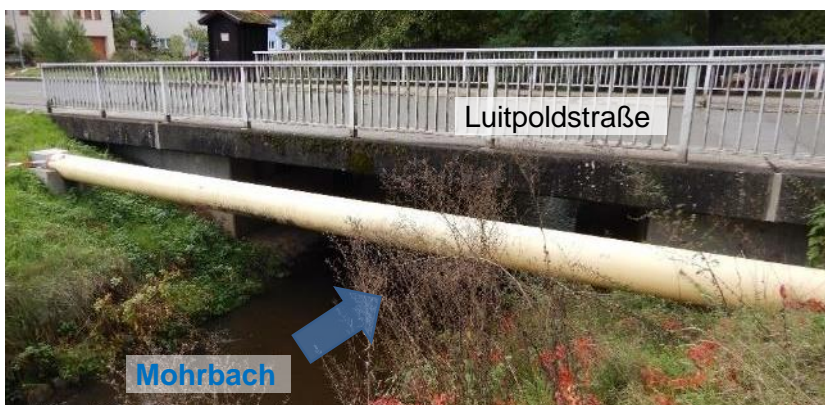
Abbildung 36 Rohrleitung Oberlauf Brücke Luitpoldstraße über den Mohrbach
