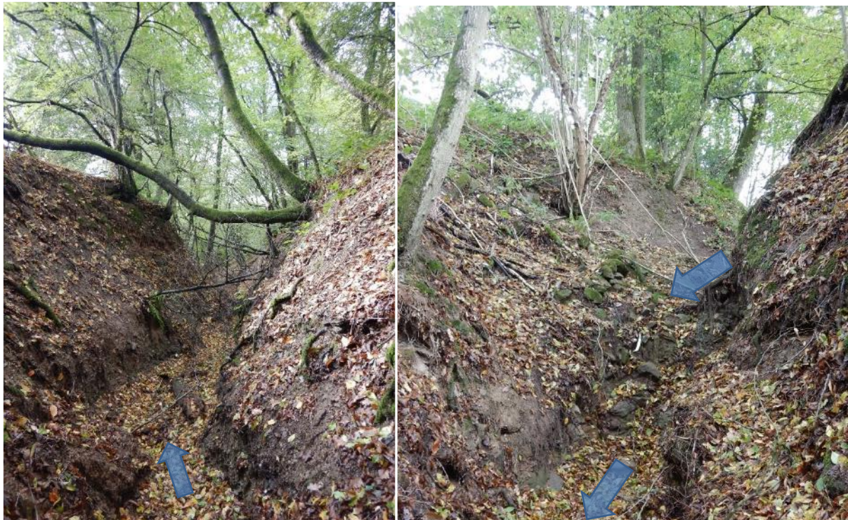
Abbildung 48 erodierter Graben oberhalb Hauptstraße
