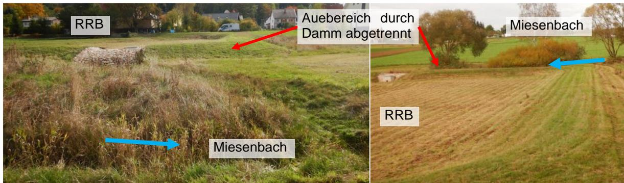
Abbildung 29 Regenrückhaltebecken Neubaubereich in der Aue des Miesenbachs
