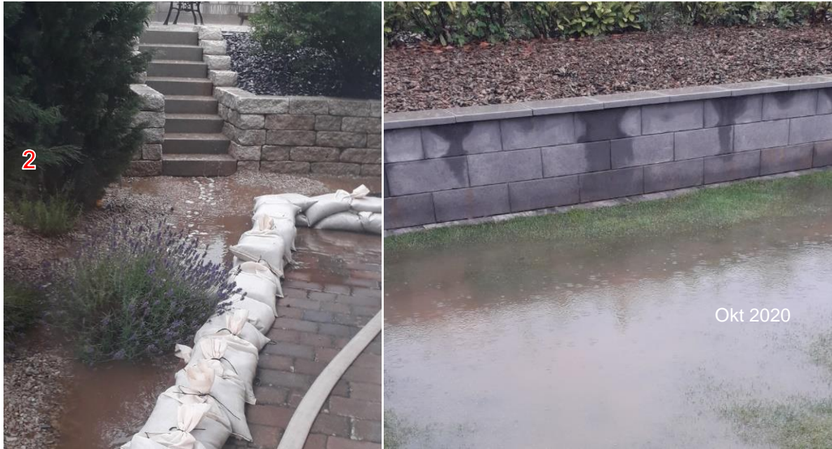
Abbildung 32 Überflutung im Gelösch Nr. 14
