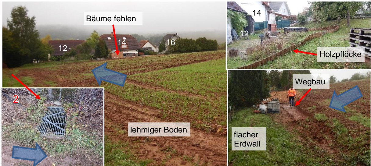
Abbildung 30 Situation Außengebietswasserzufluss Im Gelösch
