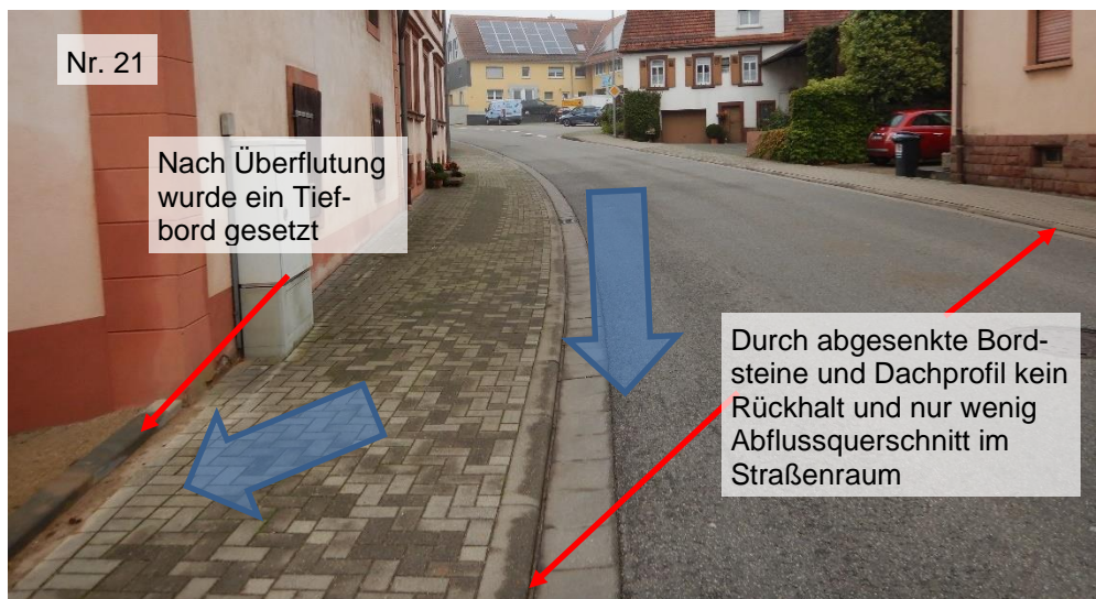
Abbildung 18 Situation Bereich Moorstraße 21
