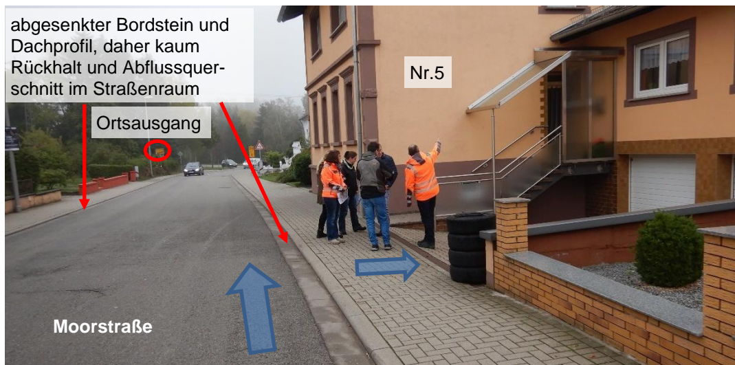
Abbildung 20 Situation Moorstraße 5 Richtung Ortsausgang
