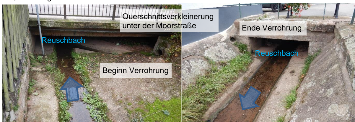
Abbildung 35 Verrohrung Reuschbach
