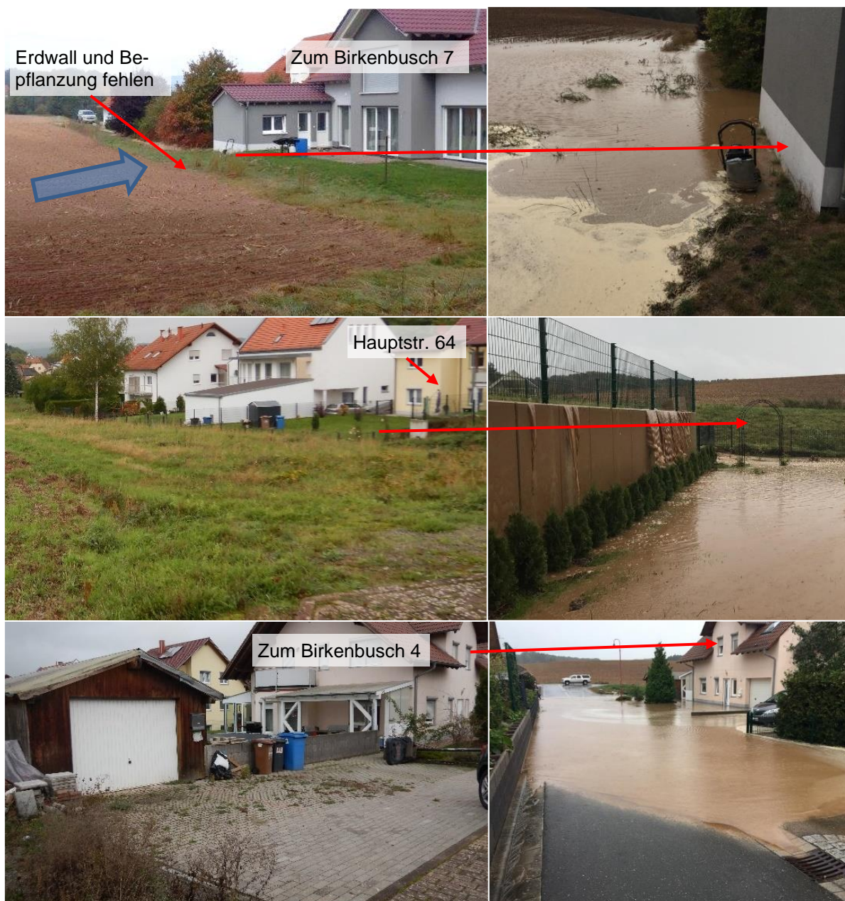
Abbildung 45 Überflutungssituation Zum Birkenbusch
