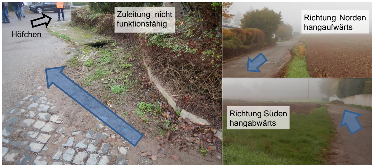
Abbildung 15 Situation Hanglage oberhalb Höfchen - Einlaufbauwerk
