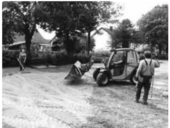
Auf dem Bild: 1. Beigeordneter Hermann Jung mit Mitarbei- tern des Bauhofs bei den Planierarbeiten
