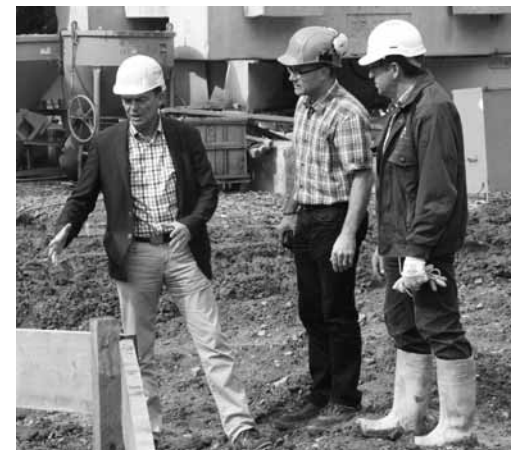
Auf der Baustelle der neuen Kläranlage Niedermohr
