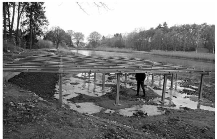
**Die Fundamente der Steganlage sind fertig gestellt. Dahinter entsteht das Kneippbecken. (Fotos: Benjamin Hüge)**
