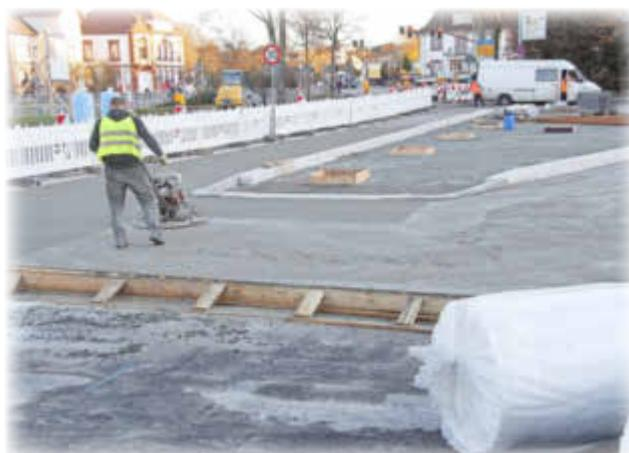
Bis in den späten Abend wurde die betonierte Fläche abgeschliffen.
