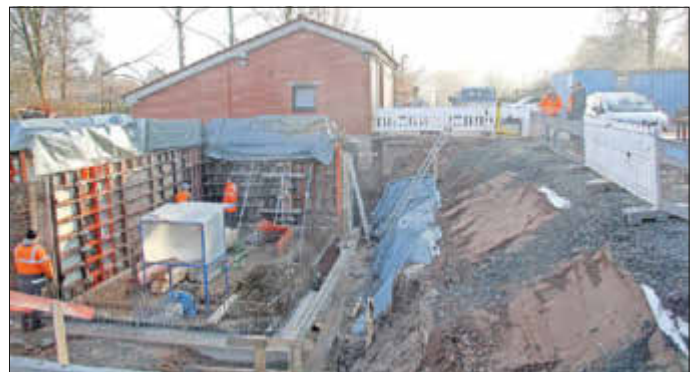
Die Bauarbeiten für das neue Pumpwerk begannen im September 2019 (Foto: Archiv VG)
