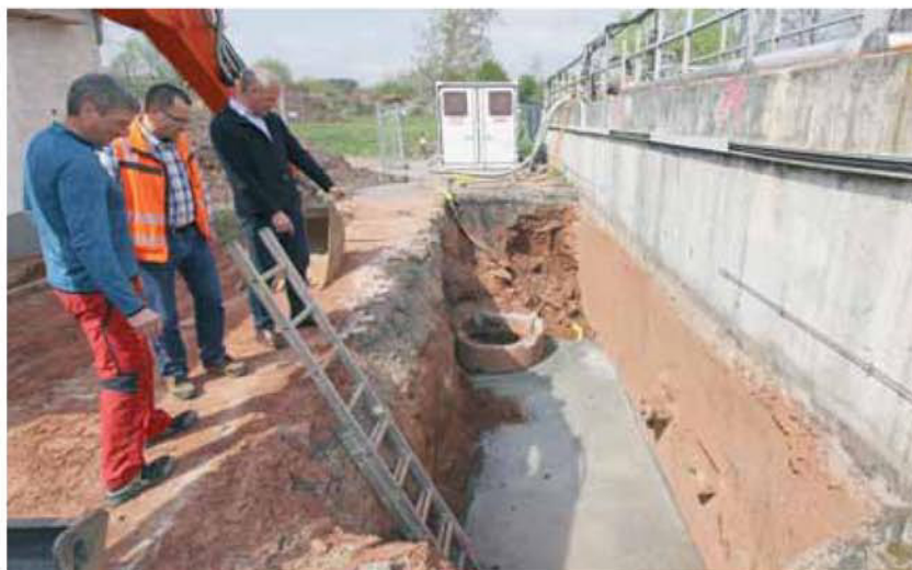
Abwassermeister Karl Weber (links), Kanalwerkleiter Steffen Harth (Mitte) und Bürgermeister Ralf Hechler (rechts) besichtigen die Bauarbeiten (Foto: B. Hüge).
