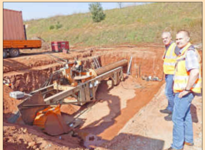
In der Startgrube arbeitet sich der Bohrer durch den Sandsteinfels Richtung Zielgrube. Rechts der Leiter des Kanalwerks, Steffen Harth und Bürgermeister Ralf Hechler (Foto: U. Simon)
