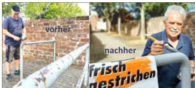
Das rostige Geländer vorher und frisch gestrichen nachher. Jürgen Brill hat ganze Arbeit geleistet.
