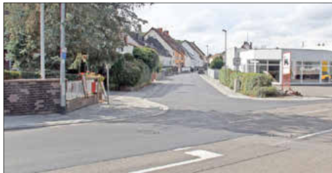
Sieht neu aus - und ist es auch: die Straße „Am Heiligenwoog“ wurde komplett erneuert (Foto: St. Lays).
