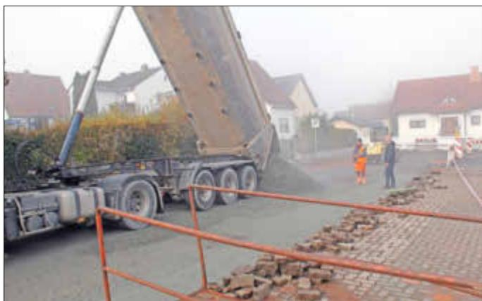
In der Lilienstraße in Ramstein sind seit vergangener Woche alle Hausanschlüsse fertig und die Verlegung der Versorgungsleitungen für Strom, Gas, Wasser und Breitband abgeschlossen. Das Material für den Unterbau der Straße wurde eingearbeitet. Als nächste Schritte folgen das Setzen der Tiefborde für die Abgrenzung von Straße und Gehweg und die Verlegung der Rinnen samt Straßeneinläufen. Wenn alles gut läuft und das Wetter mitspielt, könnte es Anfang Dezember noch mit der Fertigstellung klappen.
