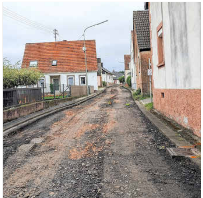
Der alte Straßenbelag in der Friedhofstraße ist ausgefräst.
