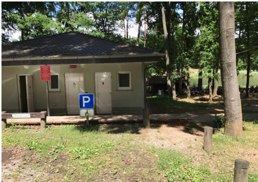
Blick von der „Waldstraße“ im Südwesten auf die baulichen Anlagen am südlichen Uferbereich
